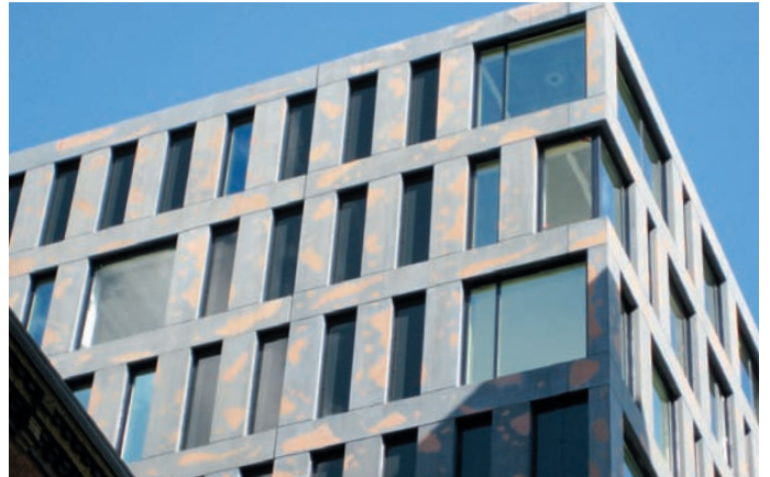
CLAUS EN KAAAN, GEBOUW D TE AMSTERDAM
